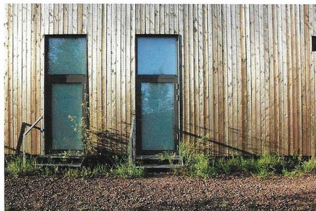
▲ Façade en bardage de pin autoclave
